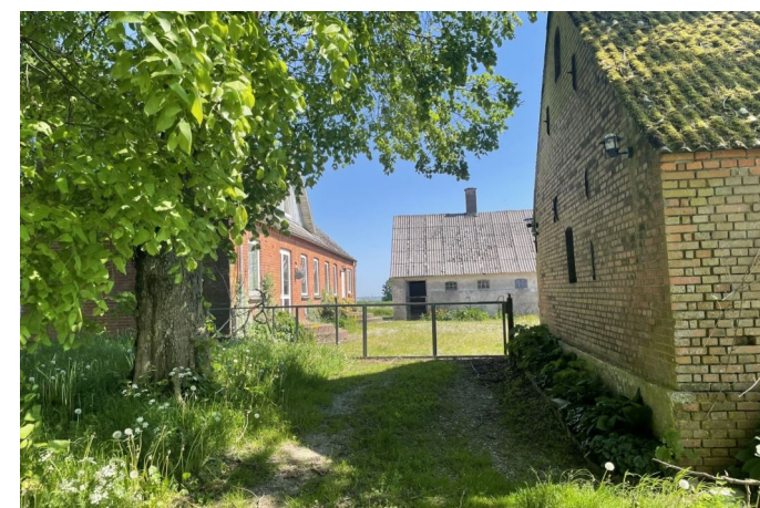
Bygninger til nedrivning
