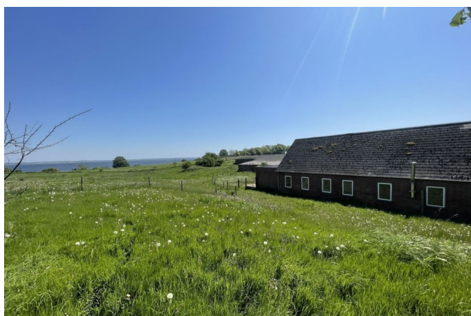
Grund - hus til nedrivning
