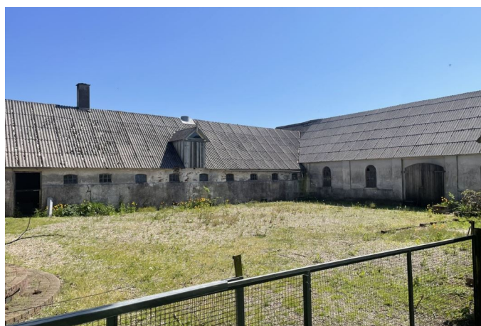
Bygninger til nedrivning
